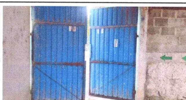
Foto 4: REPACION DE PORTON DE ACCESO, SE CAMBIARA LA ESTRUCTURA Y SE CAMBIARAN LAS BISAGRAS, LA LAMINA Y SE PINTARAN DE NUEVO
