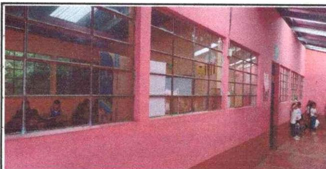
Foto 6: CAMBIO DE VENTAL A PVC Y BALCONES, SE CAMBIARAN LAS VENTAS DE LADO IZQUIERDO ENTRANDO POR EL PORTON POR NUEVAS, LAS QUE YA ESTAN MUY DETERIORADAS Y LOS VIDRIOS YA NO SE ENCUETRA EN BUE
