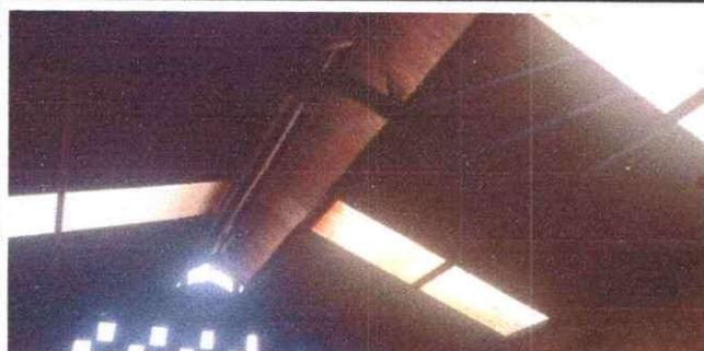
Foto1: CAMBIO DE ENTECHADO DE COCINA POR SITUACIÓN DE QUE SE ENCUENTRA MUY AUJERIADA, Y SE LEVANTA LA PALOMERA, PARA QUE VENTILE MAS EL HUMO
