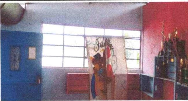
Foto 9: CAMBIO DE VENTANA DE DIRECCIÓN SE CAMBIARA LA TOTALIDAD DE LA VENTA, DE LA DIRECCIÓN Y SE LE AGREGARA UN VASTIDOR CON MALLA PARA EVITAR QUE QUIEBREN LAS VENTANAS
