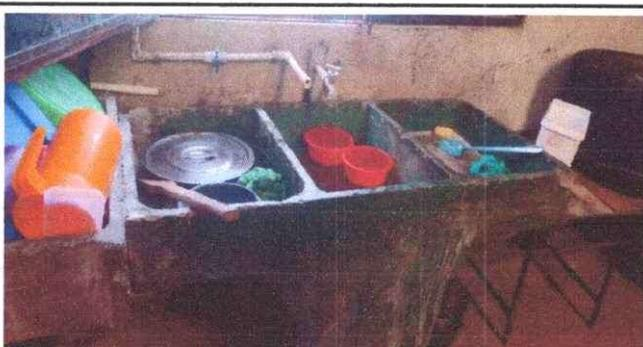
Foto 3: CAMBIO DE PILA, POR UNA NUEVA LA PILA EN USO SE CUENTRA YA RAJA EN AMBAS PILETAS AL MOMENTO DE DE LAVAR CUALQUIER COSA SE RIEGA EL AGUA SE LE DIO UN PEQUEÑO REPARO
