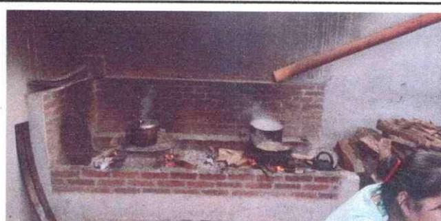
Foto 2: REMODELACION DE POLLETON DE COCINA, SE LEVANTARA CUATRO LADRILLOS MAS SE COLOCARA, UNA PLANCHA Y SE REFORZARA.
